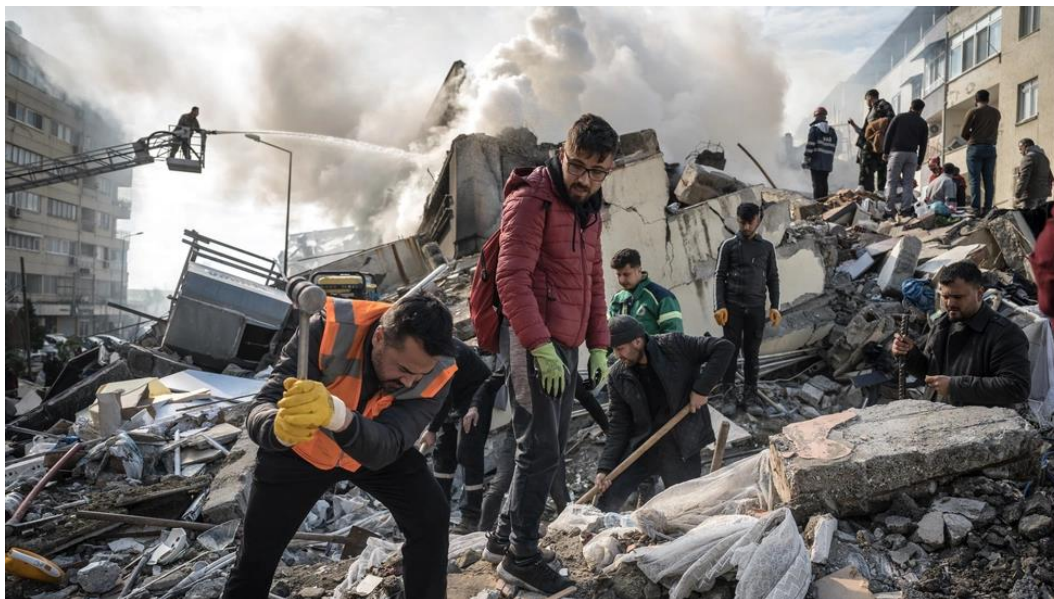
รูปที่ ๑ ความเสียหายที่เกิดขึ้นหลังเหตุการณ์แผ่นดินไหว ที่มา https://rb.gy/o5rysb
